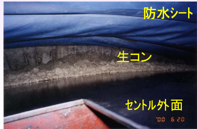
吹上げ口からの打設の状況
