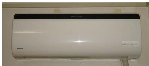
図 3 室内器（蒸発器）
